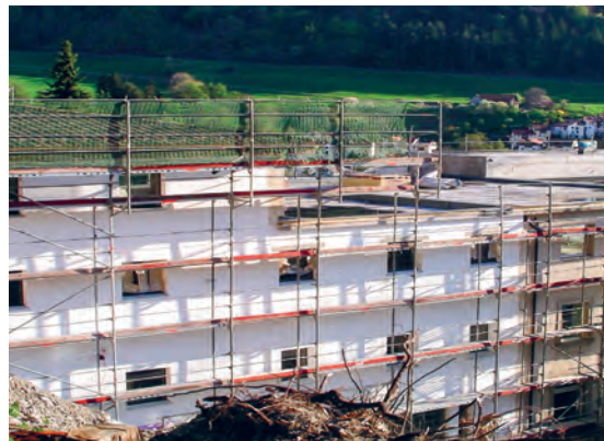
HOCHSCHULE UND SEMINAR WAREN ZULETZT 2005-2007 EINE GROSSBAUSTELLE
